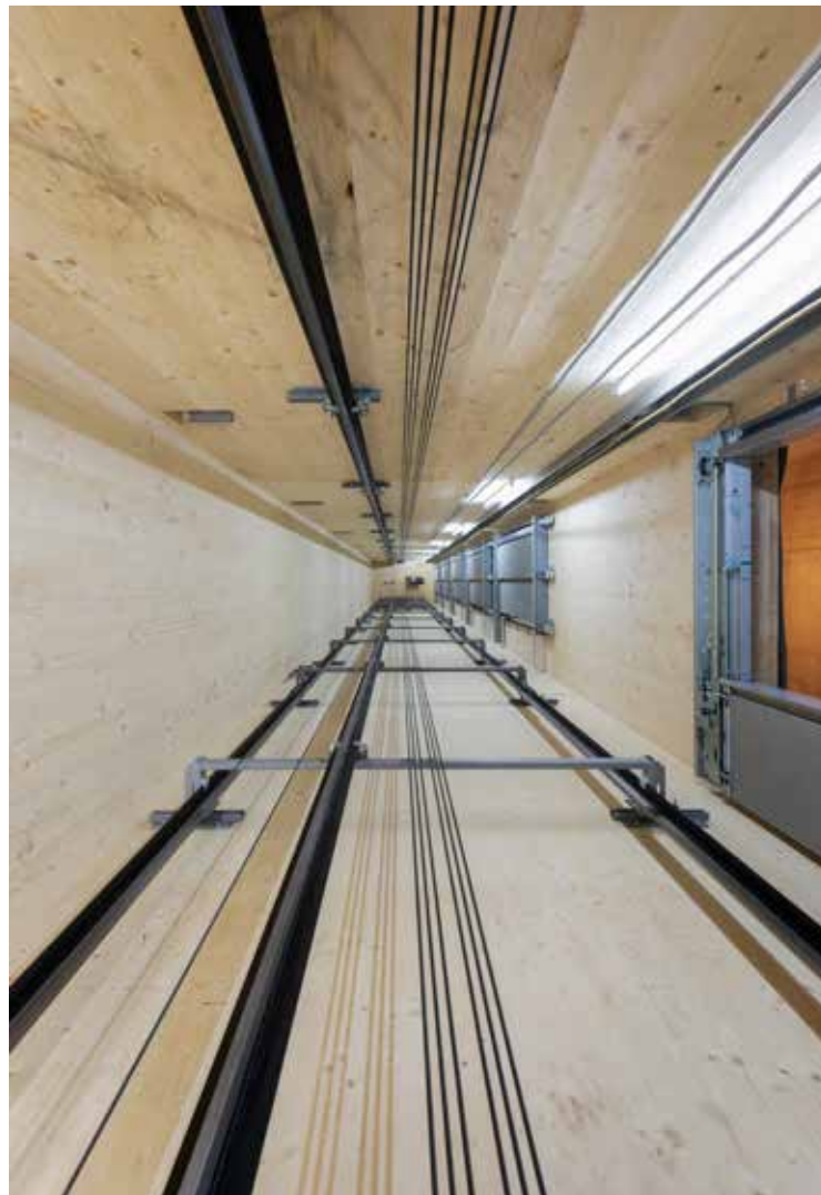
Technische Innovation: Selbst den Fahstuhlschacht konzipierten Scharabi Architekten aus vorgefertigten Holzbauteilen
