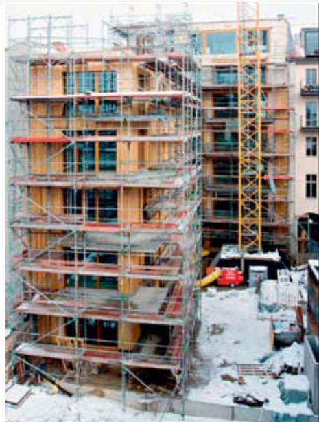
Die Lärchenverschalung machte Probleme wegen des Brandschutzes – nur sehr zögerlich erteilten die Behörden ihre Genehmigung. Fotos: Matthias Broneske
