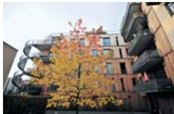
Hof-Blick Die Fassade ist auf dieser Seite mit Lärchenholz verschalt
