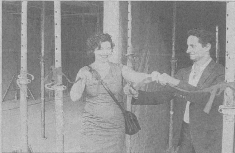
Susanne und Farid Scharabi errichten an der Fehrbelliner Straße 90 ein Haus mit einer Holzfassade. Vor wenigen Tagen gaben sie im Erdgeschoss den Startschuss für den Hochbau.
