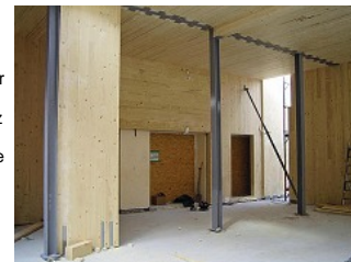
Hohe Tragkraft bei geringen Wandstärken und raschem Baufortschritt dank Fertigteilen waren Gründe für die Holzmassivbauweise. Bild: Architektin
