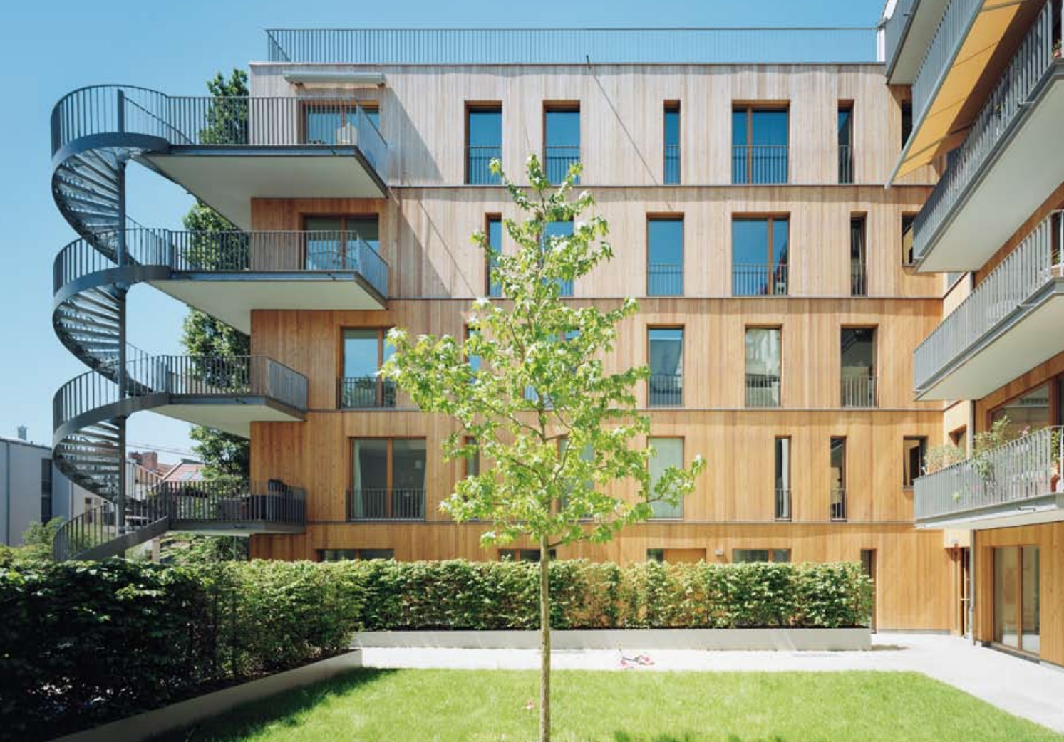
▲ Die horizontal laufenden Aluminiumbleche waren aus Brandschutzgründen notwendig, geben der Fassade aber auch eine angenehme Struktur
