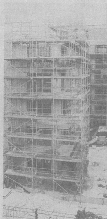
Zum Innenhof hin zielt Holz die Fassade.
